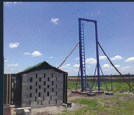
Estación de bombeo de agua - Congo
