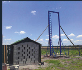
Water pump sta- tion - RDC
