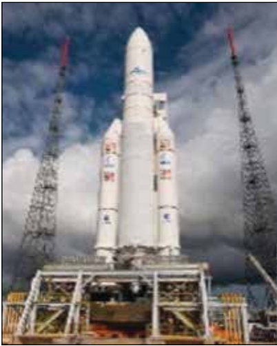
Figure 6 : Protection anti-foudre du pas de tir de Kourou.
